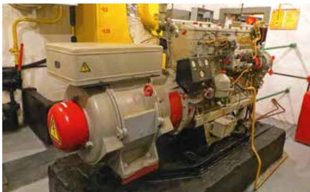
Напряжения генератора в 50 кВт достаточно, чтобы обеспечить двухсуточное пребывание в убежище 2700 человек
