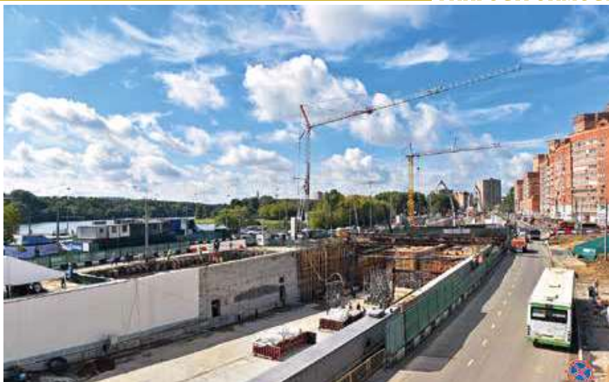
Строительство Михалковского тоннеля в Москве. Лето 2015 года
