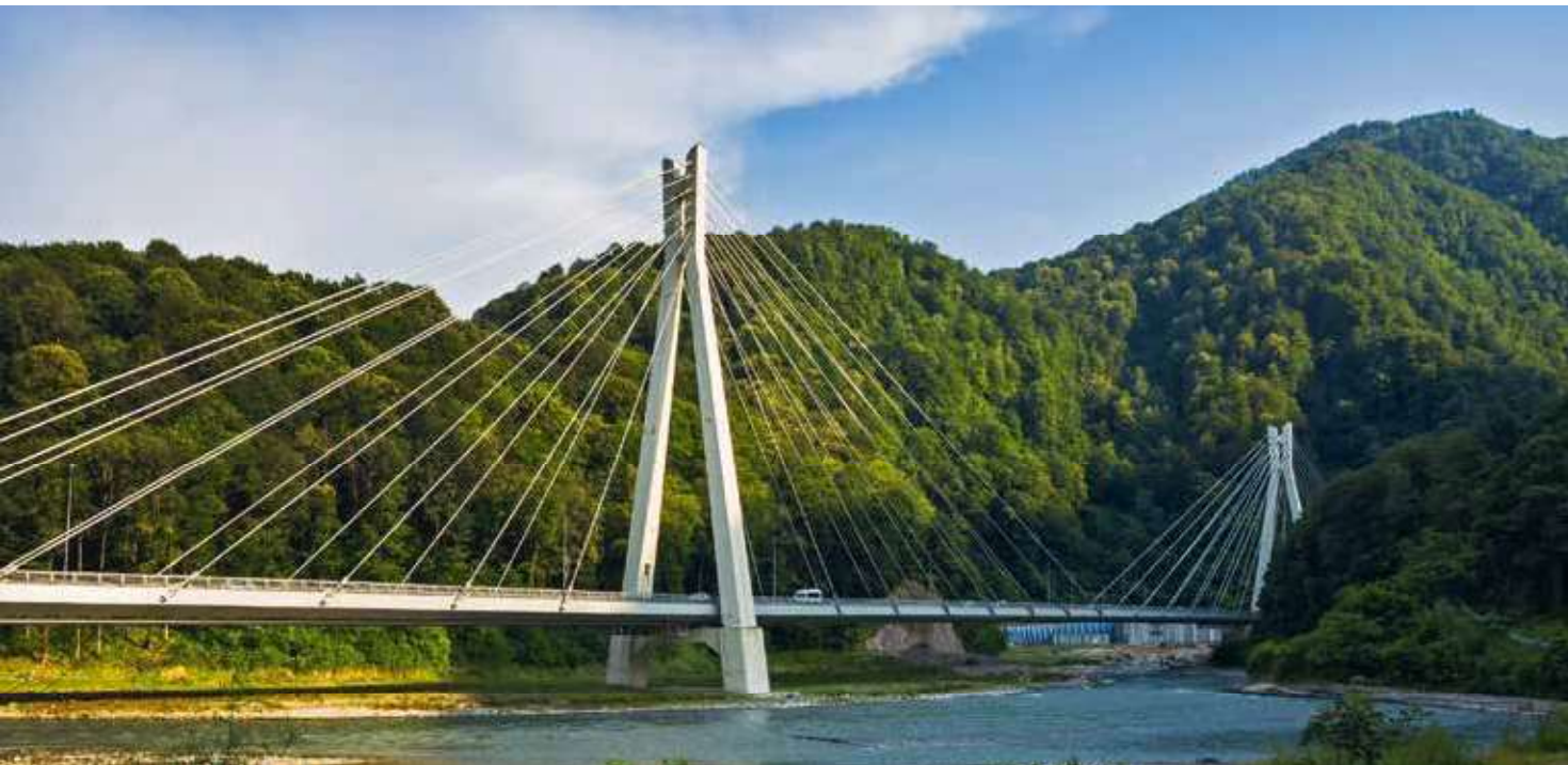
Вантовый автодорожный мост на совмещенной дороге Адлер — горноклиматический курорт «Альпика-Сервис»
