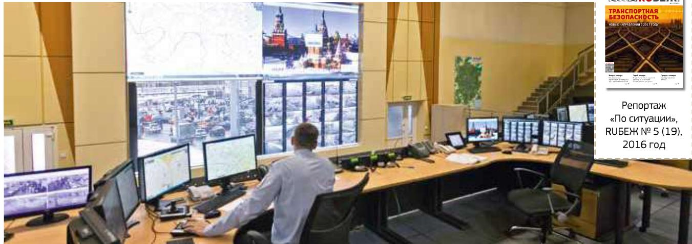
У сотрудников СЦ ГИБДД есть доступ к более чем 800 камерам фото- и видеофиксации, 2000 камер телеобзора и 144 информационным табло, установленных ЦОДД.
