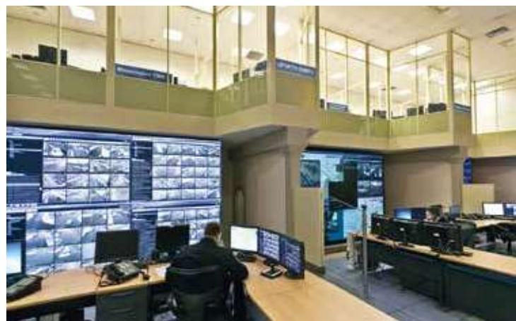
Система управления дорожным движением объединяет около 1700 светофоров с возможностью централизованного управления. Интеллектуальная транспортная система Москвы разрабатывается уже порядка 15 лет, в конце 90-х годов был начат процесс создания АСУДД — автоматизированной системы управления светофорными объектами, которая в 2000-х годах и переросла в интеллектуальную транспортную систему.
